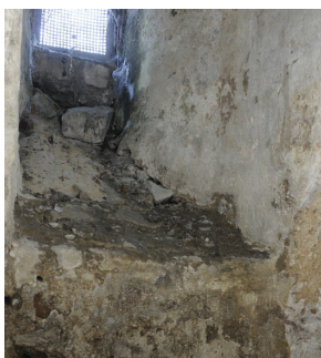
Abb. 9) Altes Mauerfundament von ca 2 m
